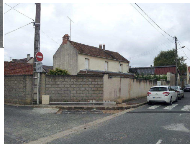
Dalle avant pose de l'armoire PRM
